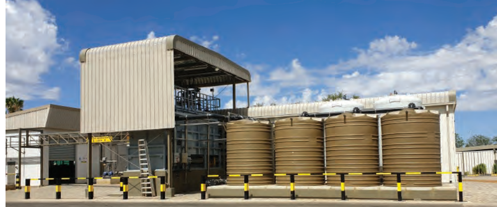
NBL: Brackish Borehole Water Actiflo-MMF-RO
